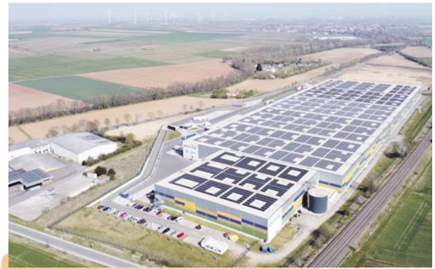
Wirsol Roof Solutions und Carbonfreed haben gemeinsam bei Pfenning Logistics in Monsheim ein Solarprojekt mit 3,74 MW erfolgreich umgesetzt. Foto: Wirsol Rooftop Solutions
